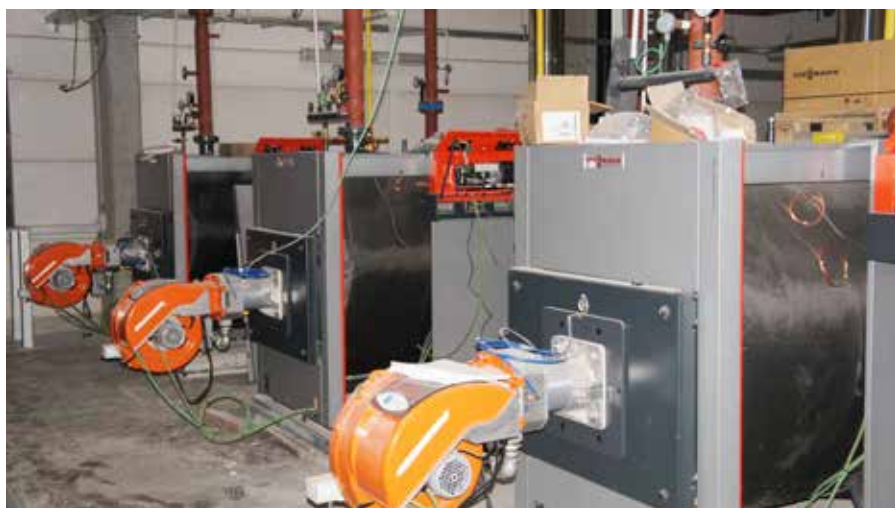
De biomassa-, WKK- en verwarmingsinstallatie staan in een apart gebouw voor de technische toestellen, met leidingen die ondergronds tot op de technische verdieping van het ziekenhuis lopen.
